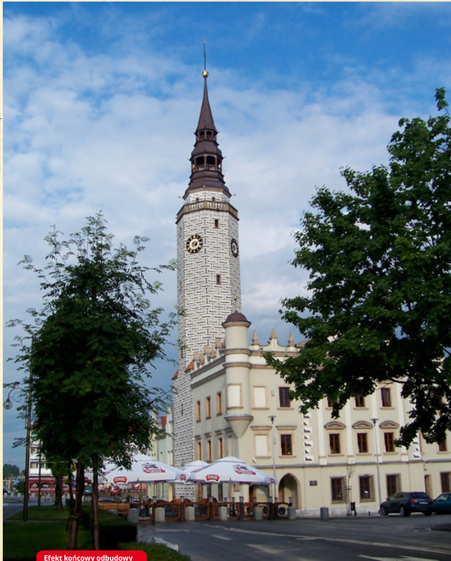
Efekt końcowy odbudowy
