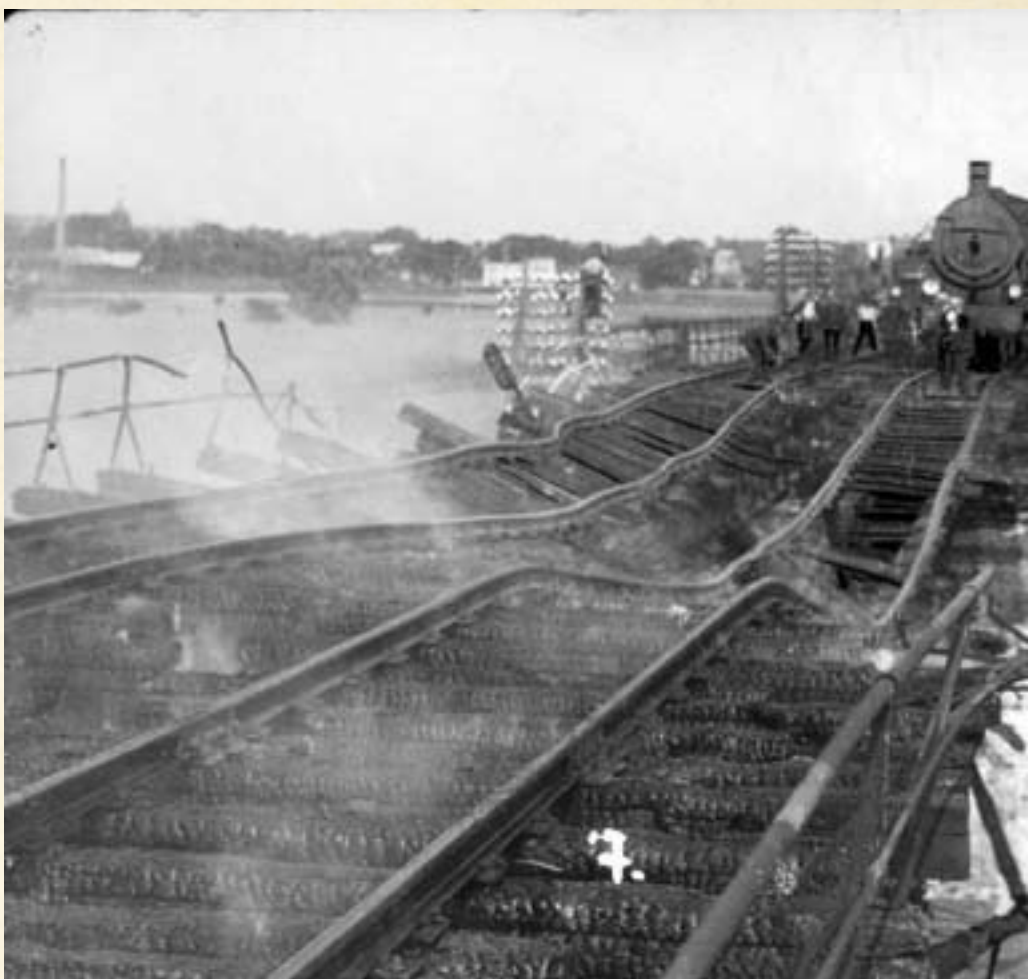
Most kolejowy w Opolu Szczepanowicach wysadzony w ramach akcji „Mosty”
